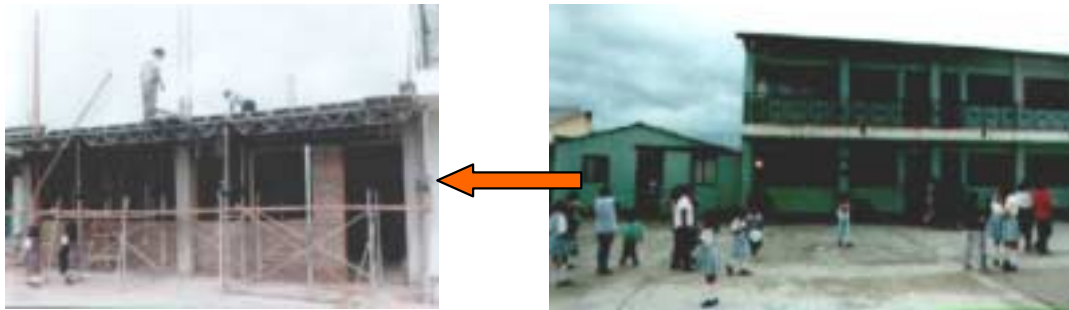
Neubau der Schule in Popayán neben dem großen Schulgebäude, das kleine Haus wurde darin integriert.
